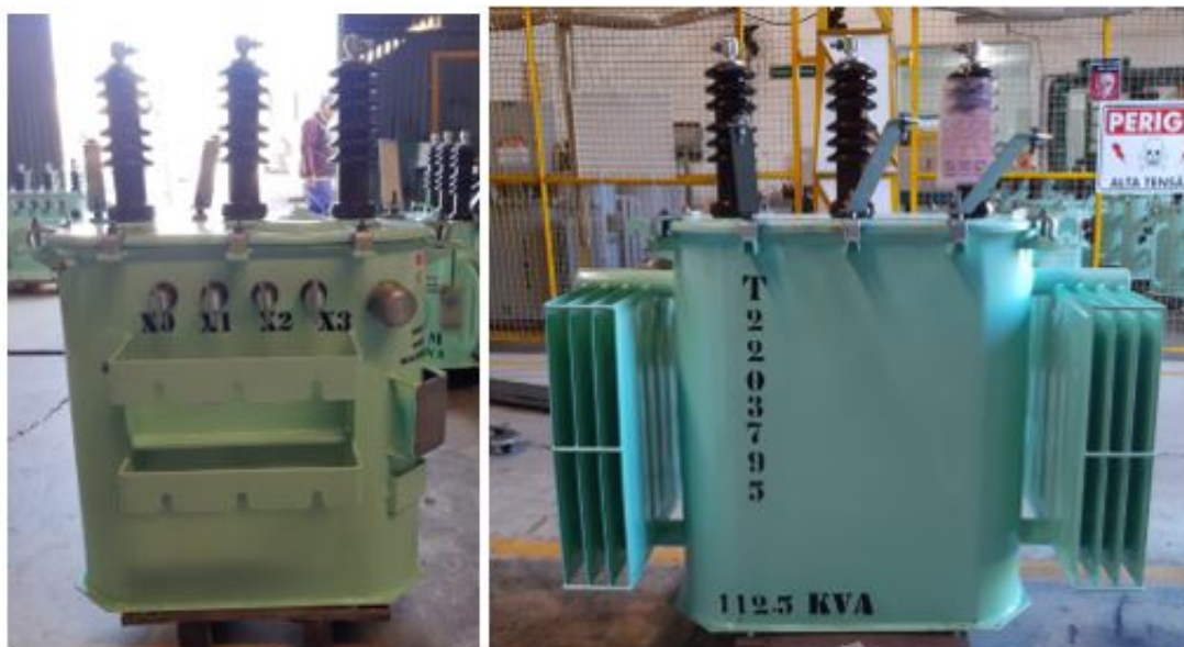
Figura 3 - Transformadores de 45 e 112,5 kVA trifásico reformados
